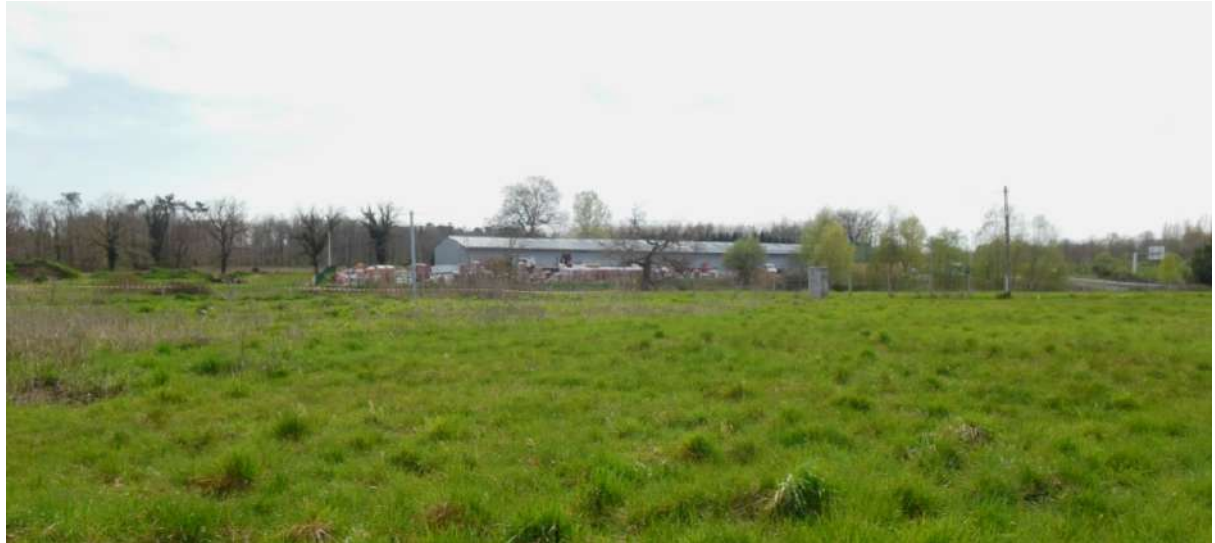
Bâtiment industriel totalement déconnecté de son environnement (Photo GEREА - Mars 2014)
